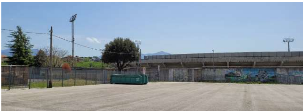
Figura 4: Foto dell'interno dell'area
