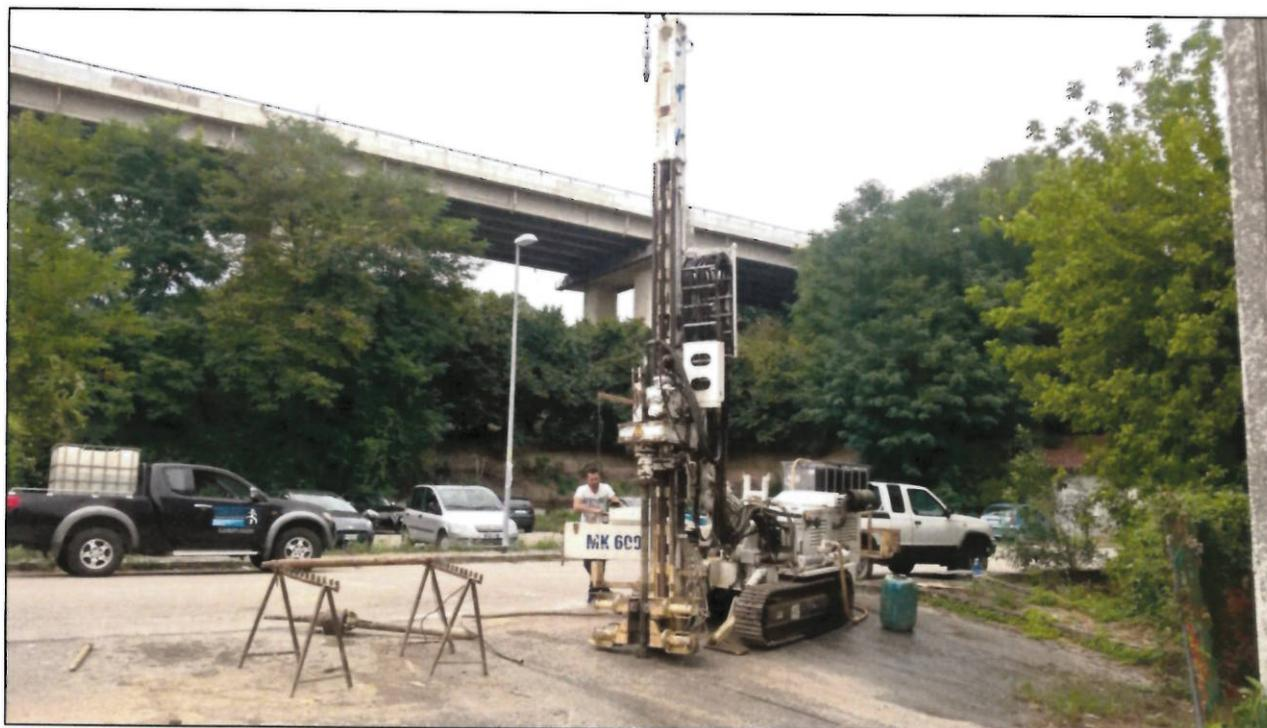
*Foto 1. –Perforazione sondaggio geognostico RU 01- S1*
