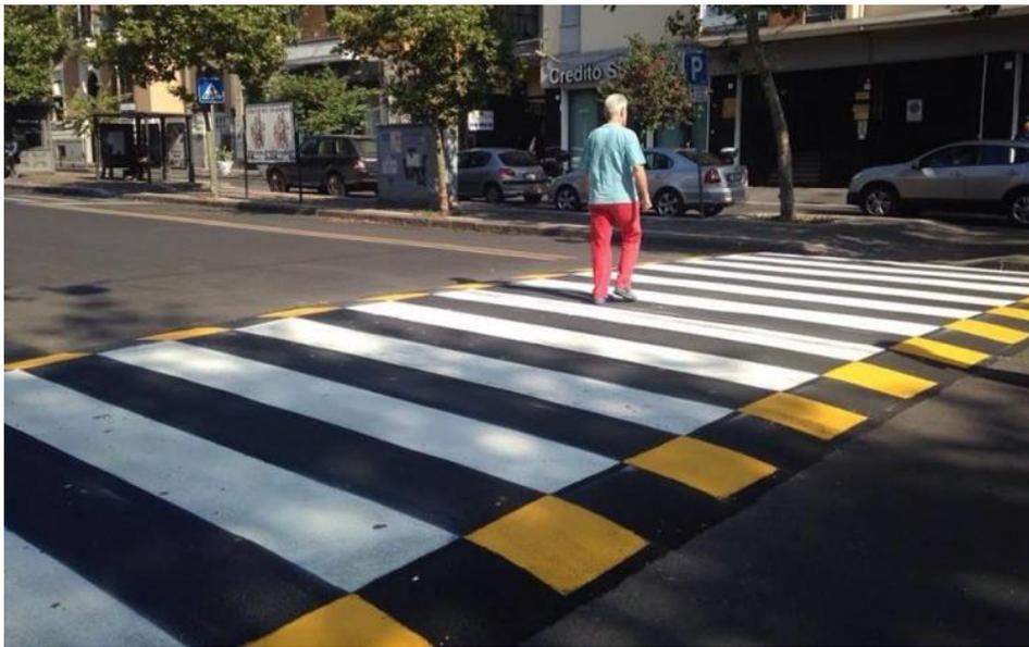
*Figura 6 - Esempio di attraversamento pedonale rialzato*
