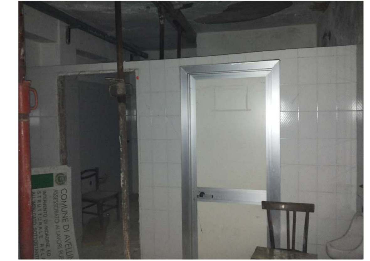
2- VISTA INTERNA AI LOCALI
