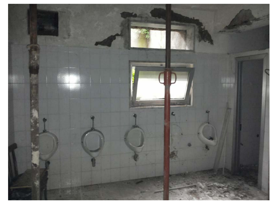
1- VISTA INTERNA AI LOCALI
