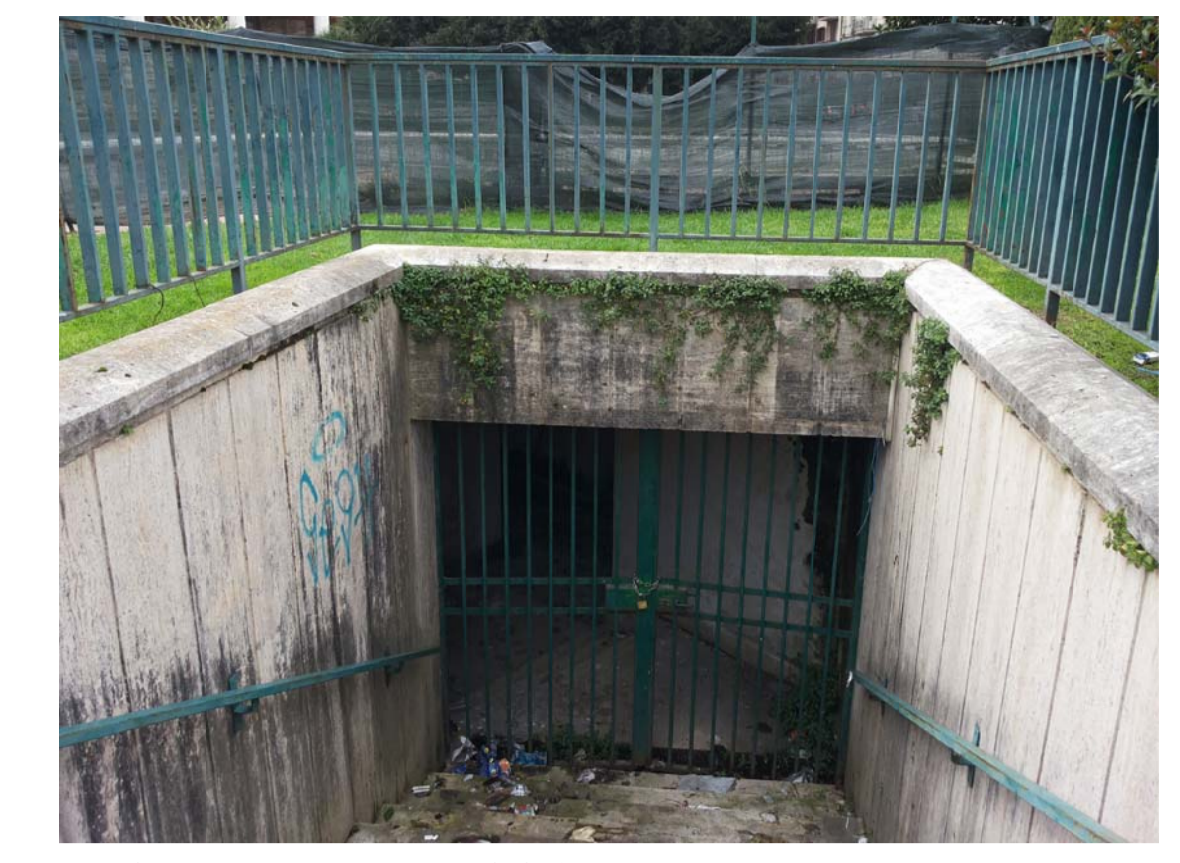
1-SCALA D'ACCESSO AI LOCALI INTERRATI
