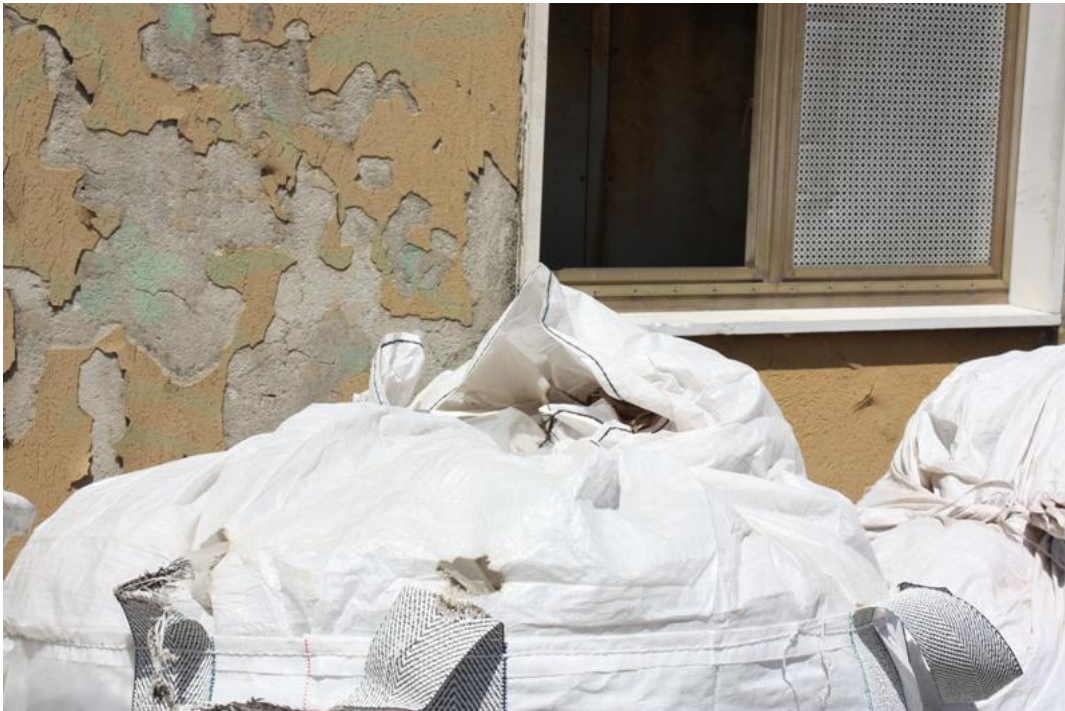
Big Bag presenti all'interno della struttura (data 3/7/2014)
